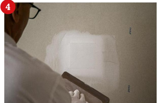
Selbstklebende, reißfeste Premium Glasfasergewebestreifen, mit einer Aluminiumplatte verstärkt. Zum Reparieren von Gipskartonplatten und Sanieren von Rissen und Löchern. Eh'klar!
